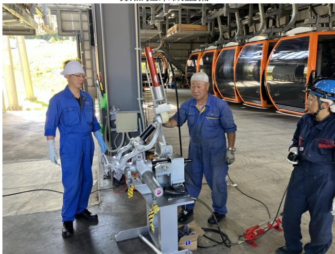
搬器握索機整備
