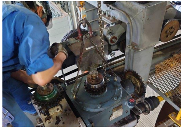
原動設備押送チェーン交換
