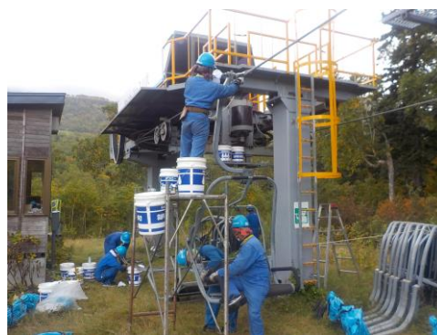
搬器取り付け整備
