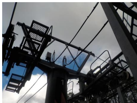
通信ケーブル更新
