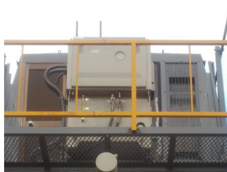
緊張油圧装置オーバーホール
