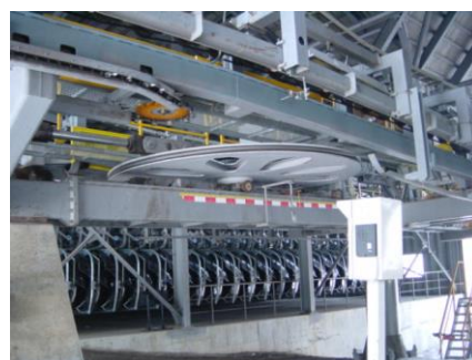
緊張滑車のゴムライナー交換
