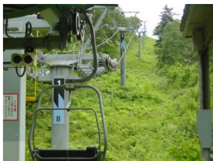
ワイヤーロープの更新交換
