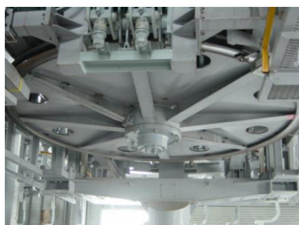
非常用制動機の分解整備
