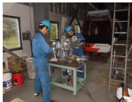
握索装置定期検査・分解整備
